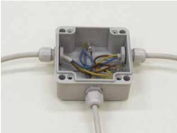
Realizzare la connessione e sigillare tutti i passaggi dei cavi con un sigillante per evitare la dispersione del prodotto.
