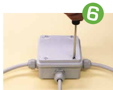
Installazione terminata Installation complete
