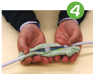
Applicare il prodotto sui contatti Apply the product onto the contacts
