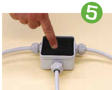
Attendere 15' per la reticolazione Wait for reticulation time 15'
