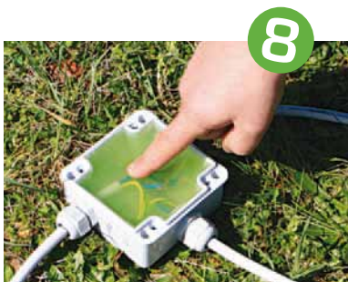
Attendere 5' per la reticolazione Wait for reticulation time 5'
