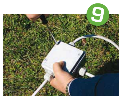
Installazione terminata Installation Complete
