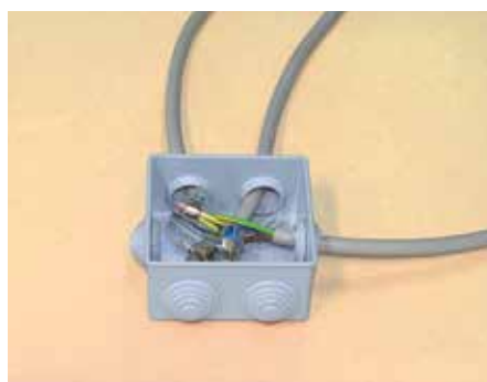
Cablare i cavi nella scatola di derivazione
